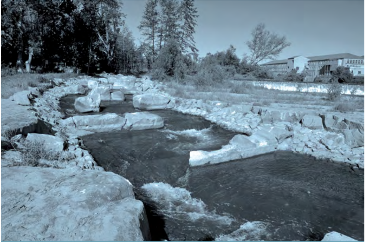
Rampa per a peixos de la resclosa de la Teula del riu Ter a Manlleu. Fotografia: Marc Ordeix – CERM.
