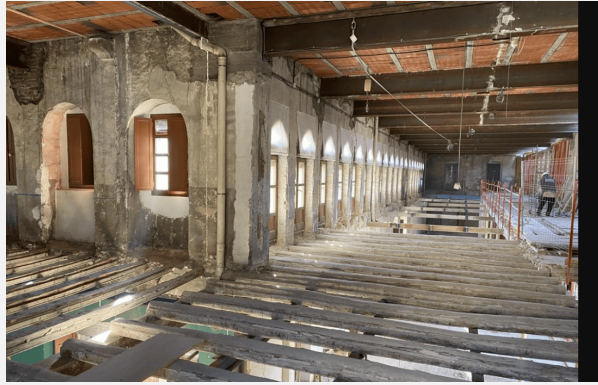
Rehabilitació dels forjats de l'edifici, març de 2021 (foto de F. Vilà).
