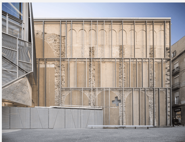
Les empremtes de l'església de Sant Ignasi, enderrocada el 1936, es remarquen en la intervenció arquitectònica (foto d'Adrià Goula).
