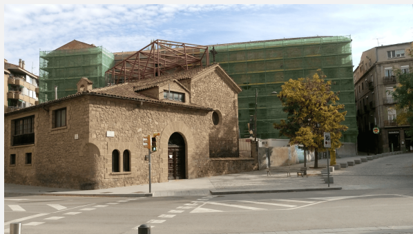
Inici de les obres a la façana oest, setembre de 2020 (foto de F. Vilà).
