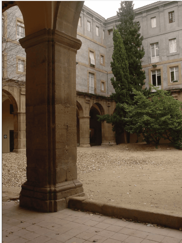
Vista del claustre abans de l'inici de les obres.
