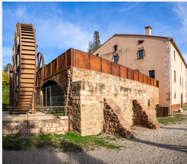
Centro del Agua de Can Font (Archivo Fundació Aigües de Manresa. Junta de la Séquia). Autor: Gonçal Portabella
